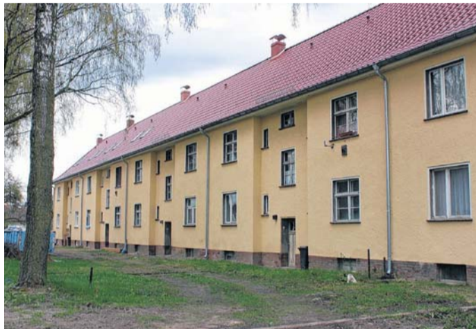
So sieht die Birkenstraße 1 bis 5 derzeit aus. Das Dach wurde neu gedeckt, die Fassade erhielt Farbe.
